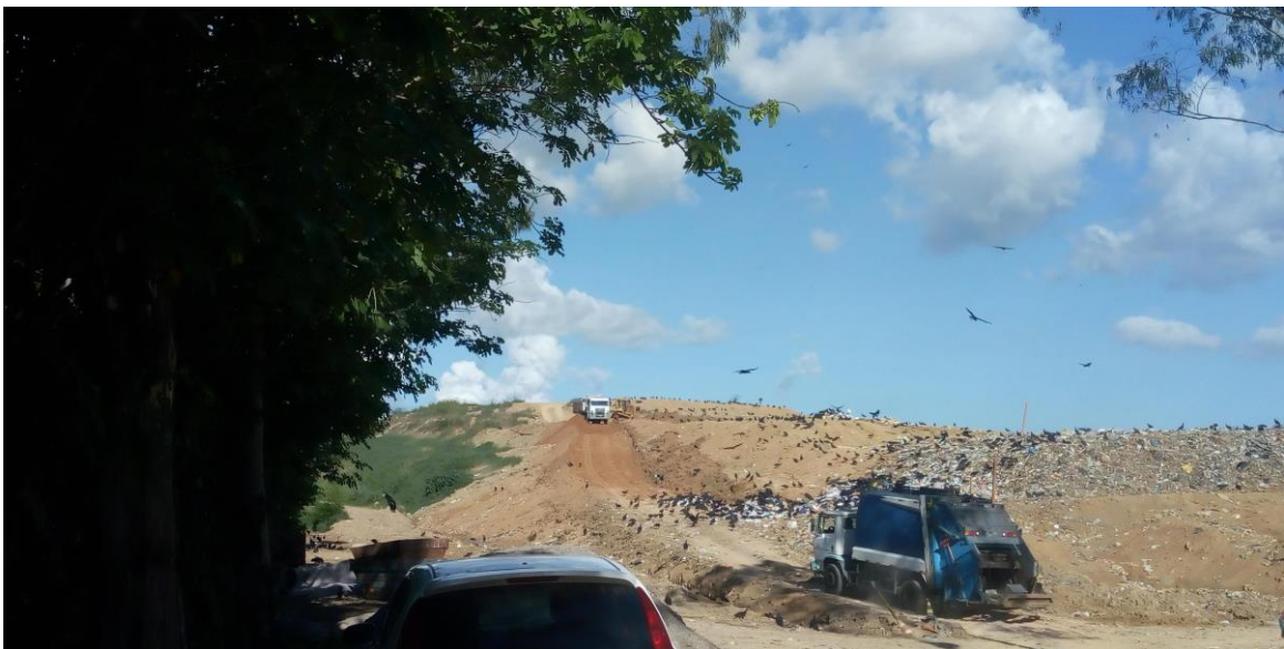
Figura 26 - Aterro Sanitário do Município de Santo Antônio de Jesus – BA
