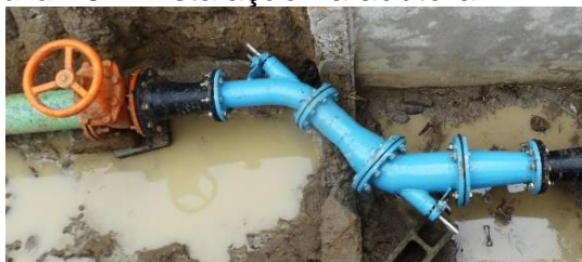
Figura 78 – Instalação na adutora
