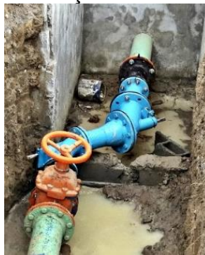
Figura 79 – Instalação na adutora (outro ângulo)
