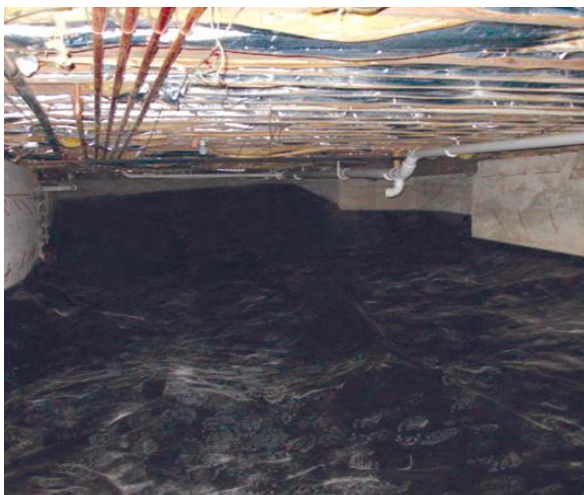
Figura 4 - Construção nova com os dutos preparados para receber um sistema anti-radônio
