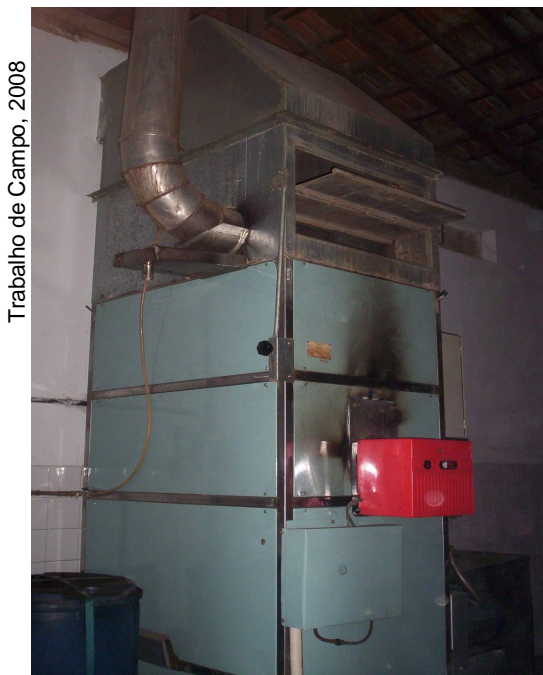
FIGURA 10- Caldeira a diesel para Aquecer a Câmara de fermentação
