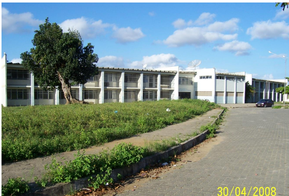
Figura 1 – Edifício do Colégio João Batista Pereira Fraga. Foto: Uziel Moreira (30/04/08).
