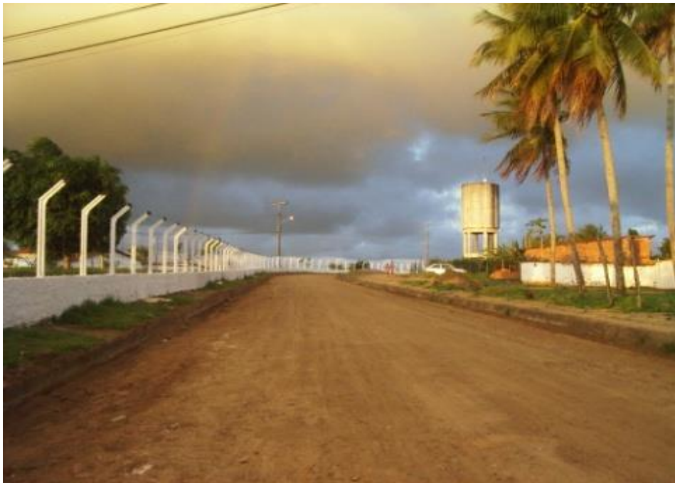
Figura 2 – Via de acesso ao Colégio Estadual João Batista Pereira Fraga. Foto: Uziel Moreira (30/04/08).
