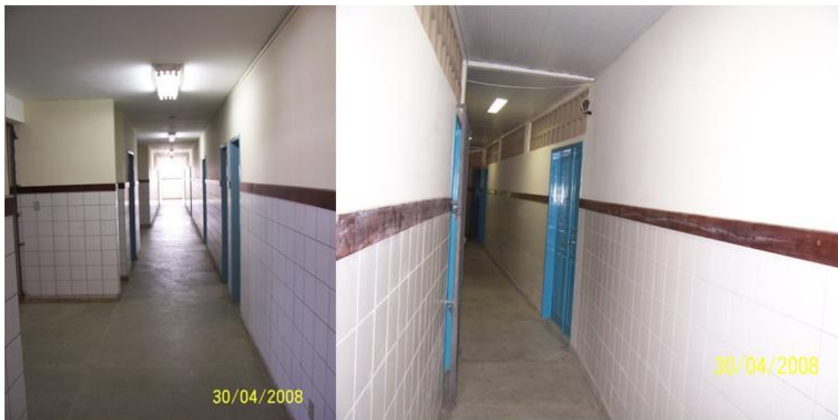
Figura 15 – Imagem interna do edifício escolar – detalhes do corredor. Foto: Uziel Moreira (30/04/2008).
